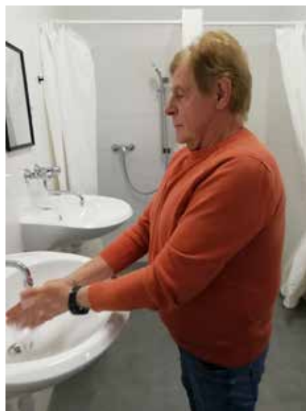
Die neuen Sanitäranlagen werden von den Gästen dankend angenommen.
